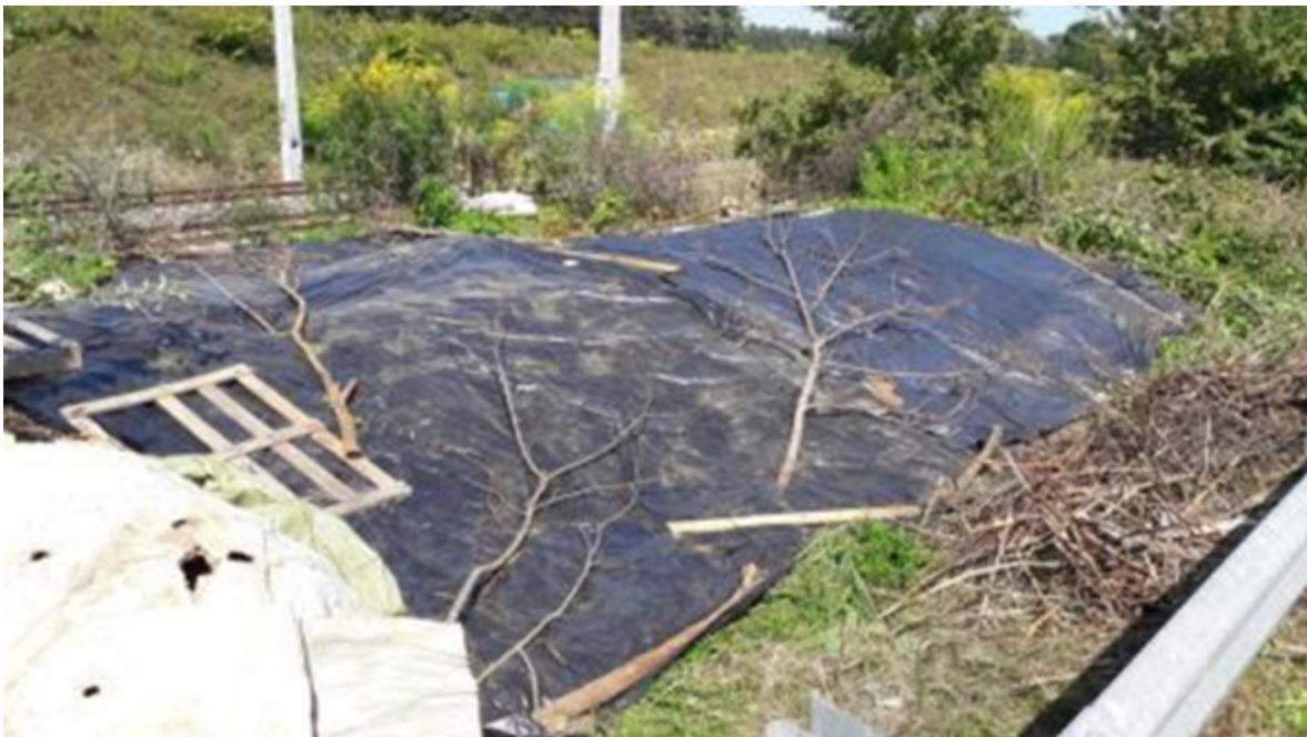
Abbildung 12: Anschließend wird die Fläche abgedeckt (Aufnahme Sattlegger)
