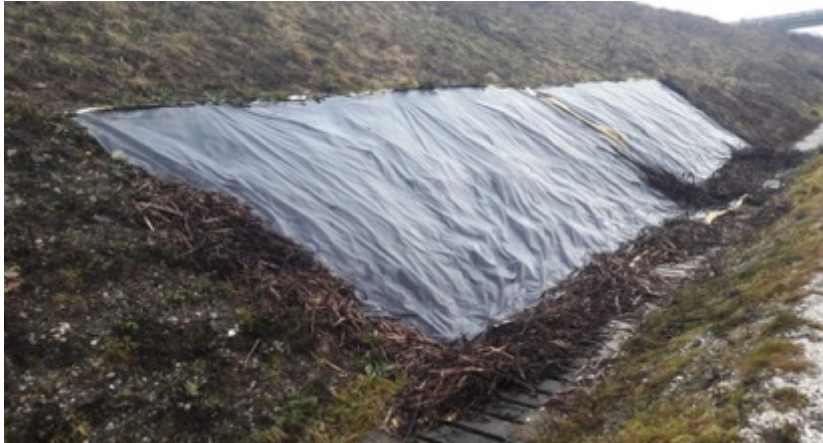
Abbildung 17: Lutzenplane liegt gut am Gelände auf. Mit den Ösen an den Rändern kann sie gut auf Böschungen befestigt werden (Aufnahme Sattlegger)
